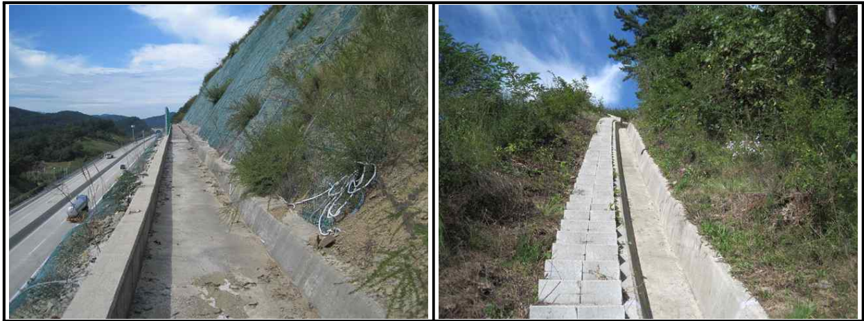
【그림 43.3.3】 배수시설 전경
